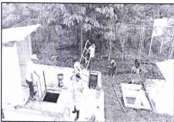
Jornada de limpieza externa de un sistema de agua
